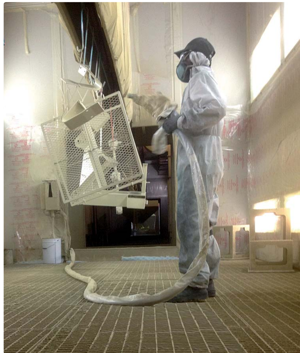
Druaga warstwa chroiąca przed korozją i powłoka wykańcająca
